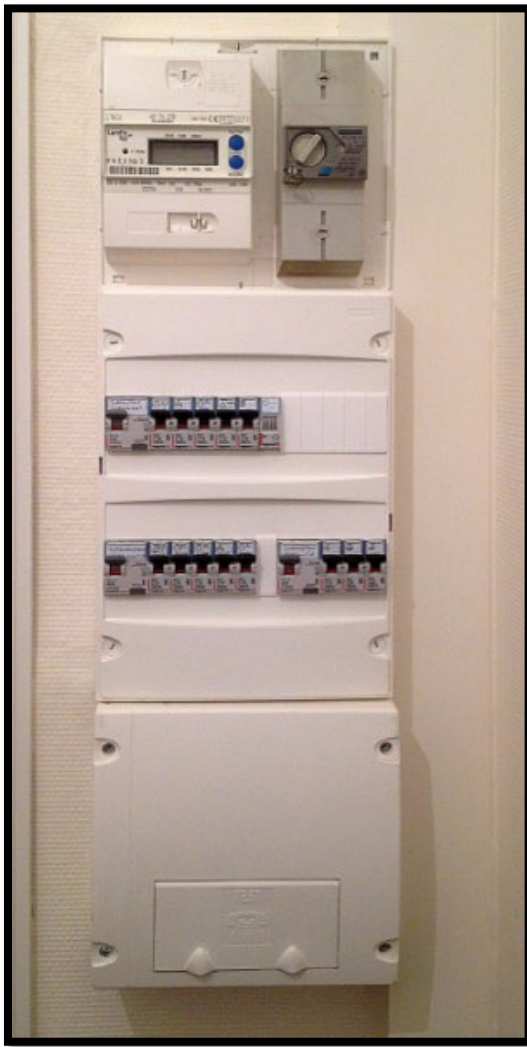
Branchement de Type 1. A gauche, un tableau divisionnaire avec son disjoncteur de branchement. A droite, le schéma correspondant.
